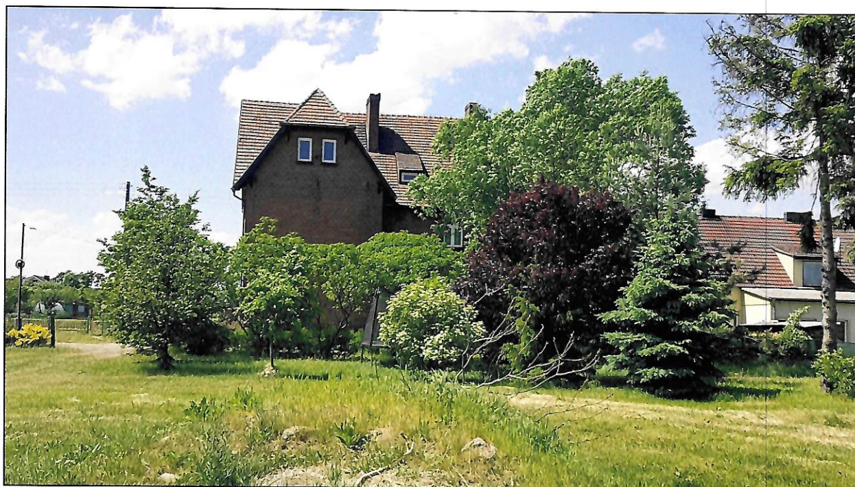
foť. 4. Widok ogólny - elewacja wschodnia; część niezabudowana posesji.
