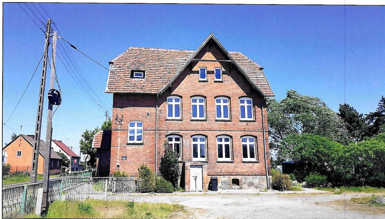
fof. 2. Widok ogólny – elewacja południowa.
